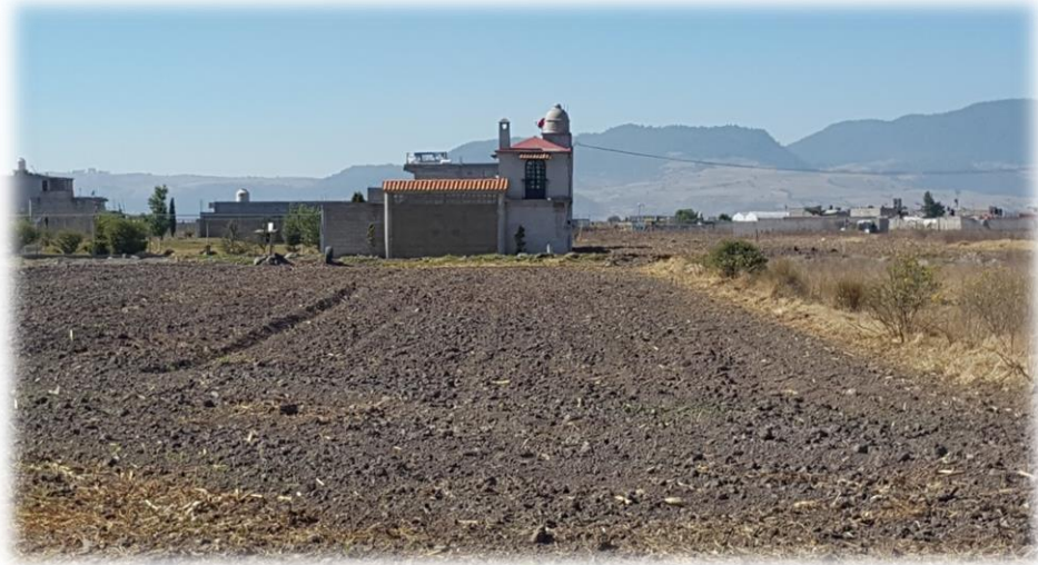
Foto 3. Vivienda autoconstruida en Chapultepec.
